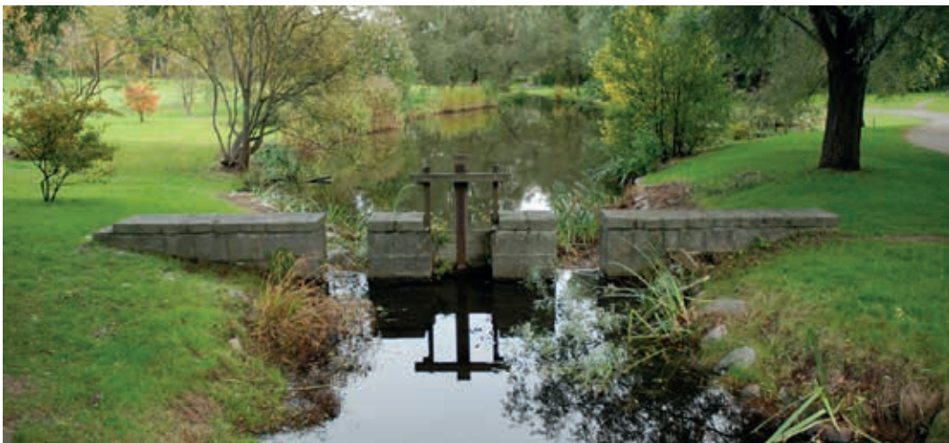
Lötsjöns regleringsdamm, Sundbyberg. Foto: Kjell Andersson
