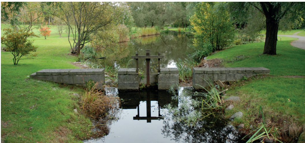
Lötsjöns regleringsdamm, Sundbyberg. Foto: Kjell Andersson
