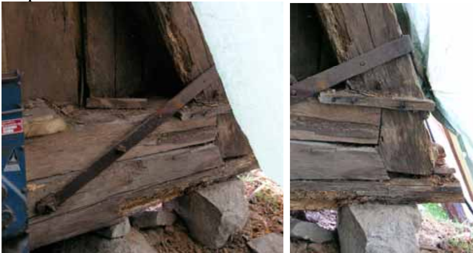
Stolphörn 1 före lagning. Lp20110039 och Lp20110040.
