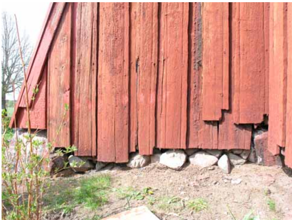
Ett av hörnen med bevarad panel och bibehållen tandad avslutning nedtill. Utrymmet mellan panel och mark tätades med nät och stenar. Lp20110012.
