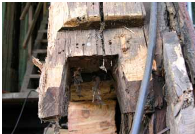
Detalj av stolpens anslutning till bjälken. Lp20110042.
