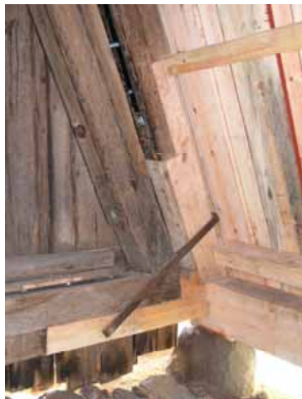
Tv. Bägge stolparna var redan lagade nedtill sedan tidigare. Th. Den yttre stolpen lagades åter samt yttre delen av den anslutande bjälken. Syllen byttes ut i sin helhet. Lp20110050 och Lp20110051.
