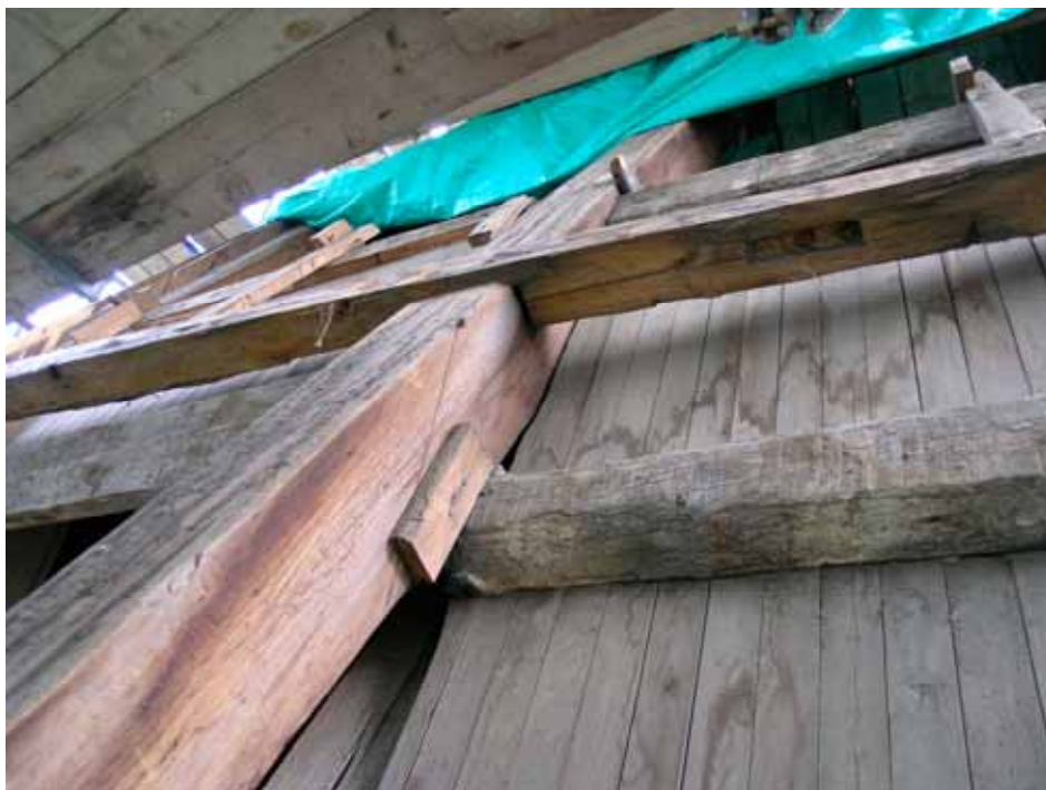
På enstaka ställen kunde tvärläkten bevaras. På västsidan fanns en äldre läkt med rektangulärt borrar urtag. Lp20110008.
