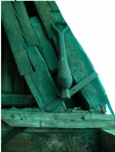
Tv. Bägge stolparna var redan lagade nedtill sedan tidigare. Th. Den yttre stolpen lagades åter samt yttre delen av den anslutande bjälken. Syllen byttes ut i sin helhet. Lp20110050 och Lp20110051.
