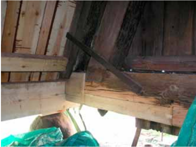
Stolpparet var i gott skick och lämnades utan åtgärd. Anslutande bjälke lagades i den yttre delen. Södra syllen byttes i sin helhet. Lp20110022.
