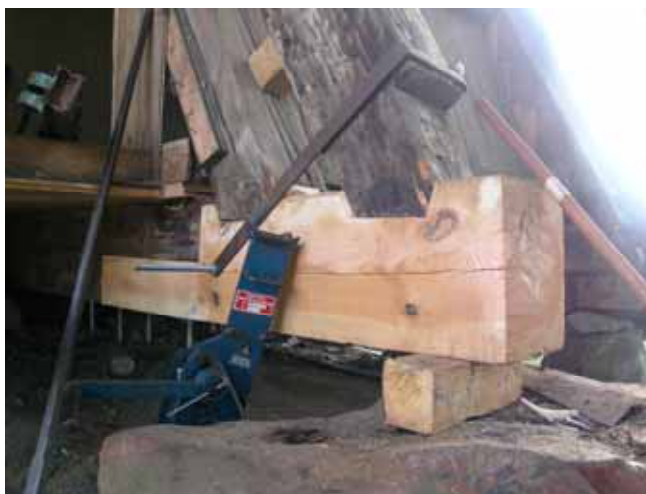
Samma lagning från nord. Lp20110026.
