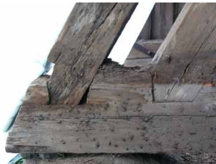
De dubbla stolparna ansluter bjälken i sneda hak. Detalj från norr. Lp20110044.
