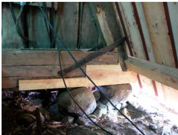
Bjälke efter lagning och med ny panel. Lp20110043.
