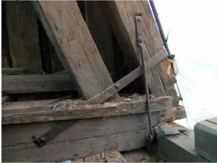
Nordsidan var i gott skick och rensades endast från ytliga rötskador. Lp20110031.
