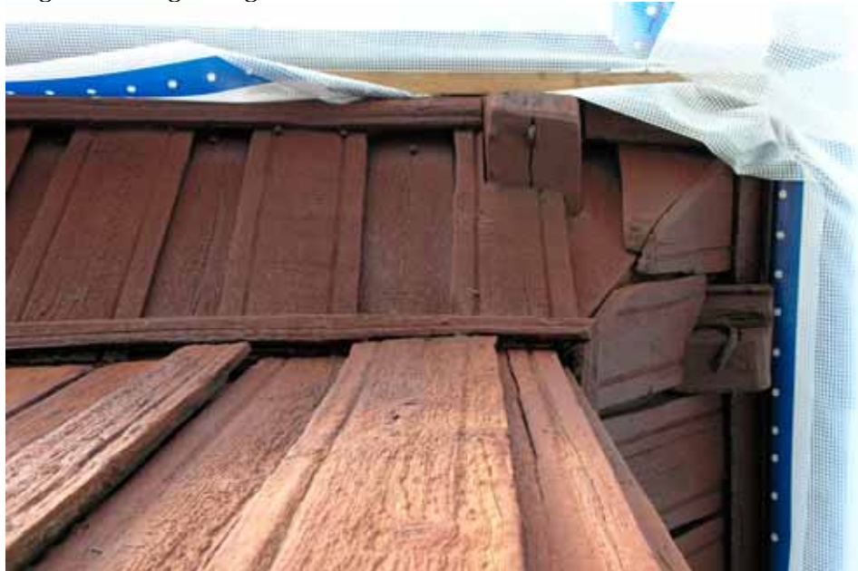
Detaljbild av klockstapelns takfot. Panelen var i gott skick och lämnades utan åtgärd. Lp20110006.
