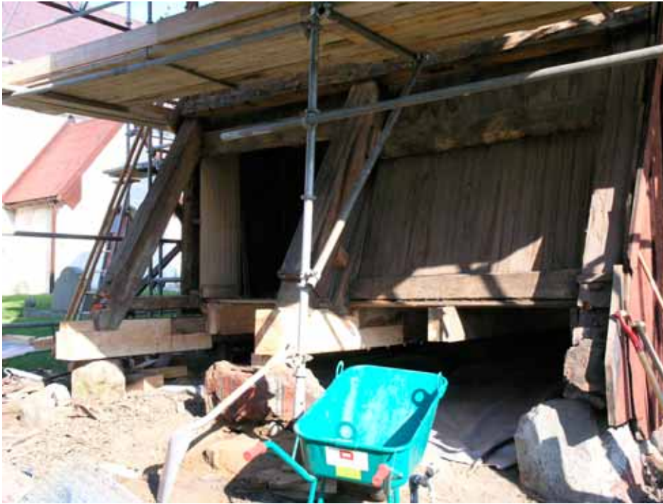
Västra sidan under reparation. Två bjälkar tillhörande bottenbjälklaget lagades. Lp20110009.
