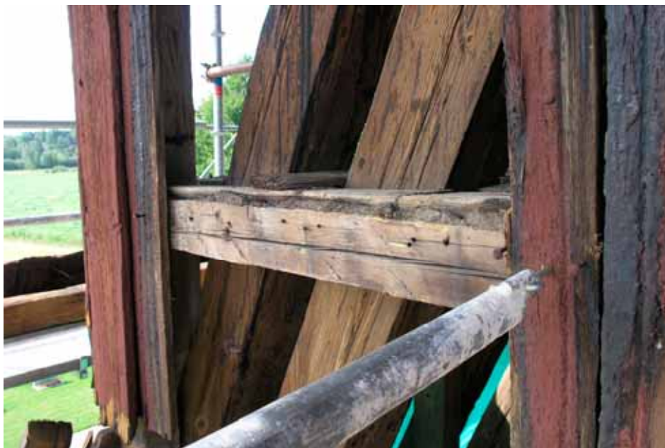
Handbilad tvärregel på östra fasaden med anslutande brädgolv och mellanliggande tätning. Lägga märke till spåren efter svart tjära på de snedställda stolparna. Lp20110003.
