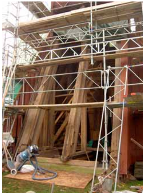
Tv. Nordsidans mittstolpe i höjd med klockväningen. Brädgolvet var något rötskadat, några brädor byttes ut. Th. Nordsidan under panelbyte med de resliga stolparna frilagda. Lp20110002 och Lp20110001.
