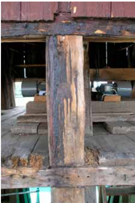
Tv. Nordsidans mittstolpe i höjd med klockväningen. Brädgolvet var något rötskadat, några brädor byttes ut. Th. Nordsidan under panelbyte med de resliga stolparna frilagda. Lp20110002 och Lp20110001.
