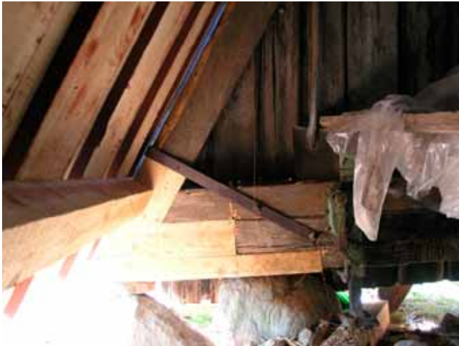
Samma hörn efter lagning och med ny panel. Lp20110049.
