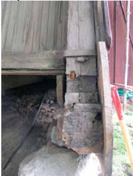
Både stolpe och bjälke var i gott skick och lämnades utan åtgärd. Lp20110023 och Lp20110024.
