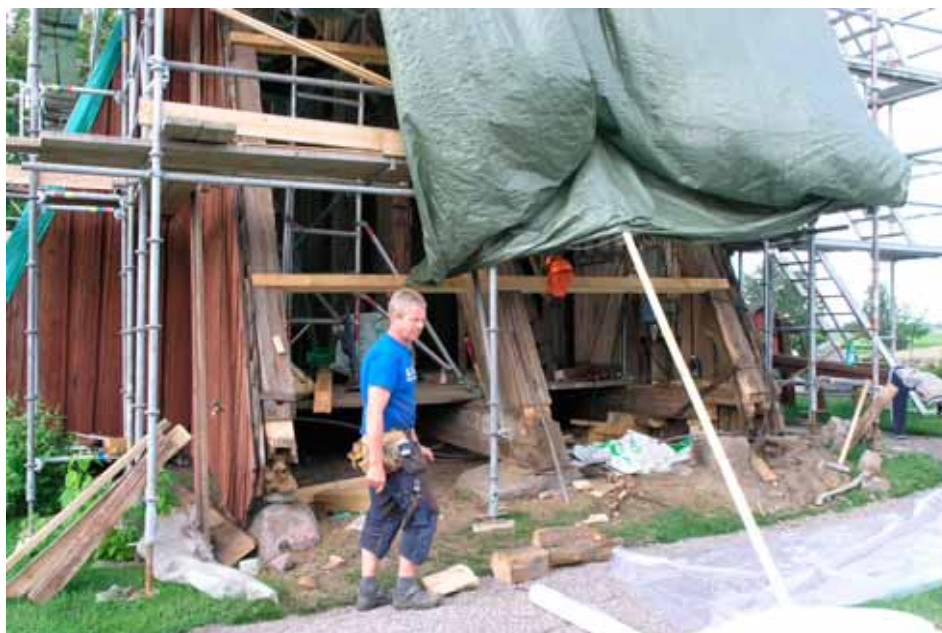
Östra sidan under reparation av bägge hörnen. Lp20110005.
