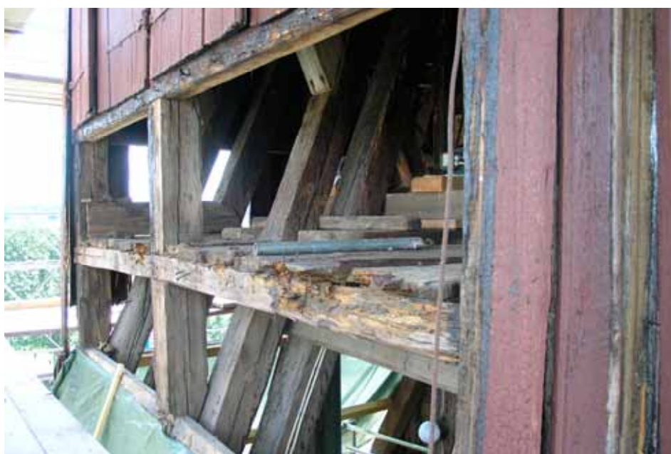
Rötskadad tvärregel på norra sidan som byttes ut i sin helhet. Lp20110007.
