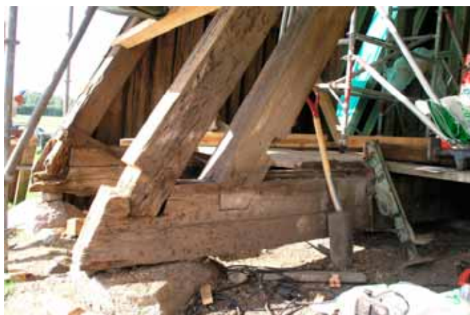
Stolpe 2 var i gott skick och lämnades utan åtgärd. Lp20110046.
