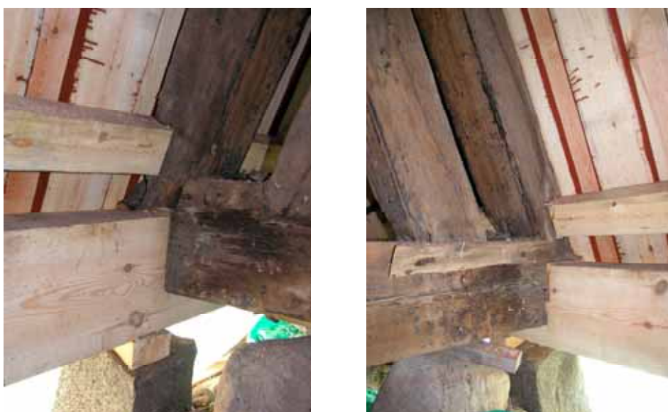
Stolpar var i gott skick och lämnades utan åtgärd. Den anslutande syllan byttes i sin helhet. Lp20110018 och Lp20110019.
