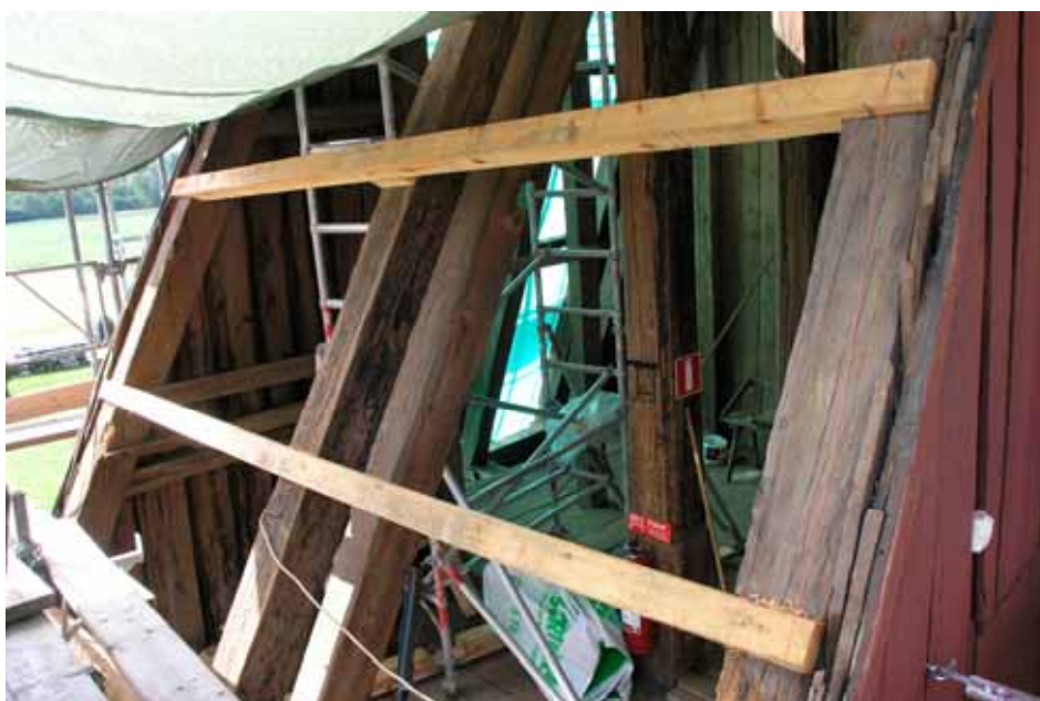
Den nya panelen fästes på ny tvärläkt av samma dimensioner som tidigare. Lp20110004.
