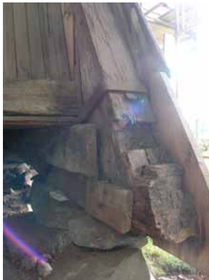
Både stolpe och bjälke var i gott skick och lämnades utan åtgärd. Lp20110023 och Lp20110024.
