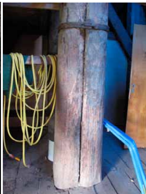
Tv. Detalj av hasp som håller en av luckorna på plats. Den handbilade stolpen har spår efter tjära. Th. Två av de tre hjärtstolparna består av två halva stockar sammanhållna med järnband. Dendroprov togs från den hela hjärtstolpen. Lp20110060 och Lp20110066.
