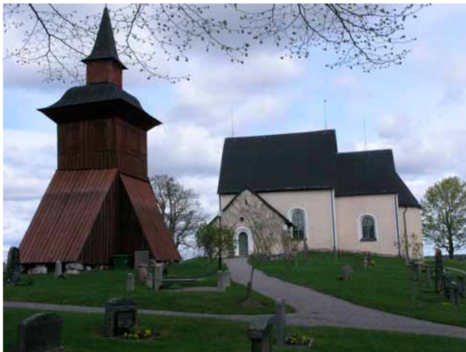
Klockstapeln före renovering från sydöst. Lp20110052.
