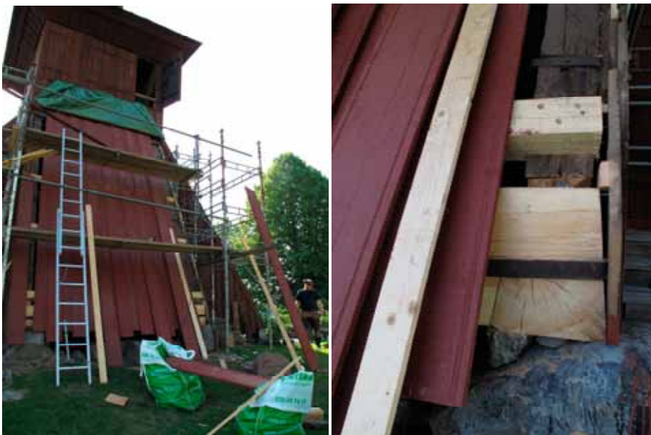
På västfasadens nedre del byttes panelen i sin helhet. Till höger syns sydvästra hörnet efter byte av västra syllen och den anslutande bjälkens yttre del. Lp20110057 och Lp20110056.
