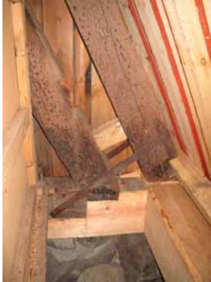
Tv. Sydvästra hörnet från insidan efter reparation av syll och bjälke. Befintliga järnband återanvändes. Th. Utrymmet mellan trägolvet och väggen täts med metallnät. Lp20110067 och Lp20110059.
