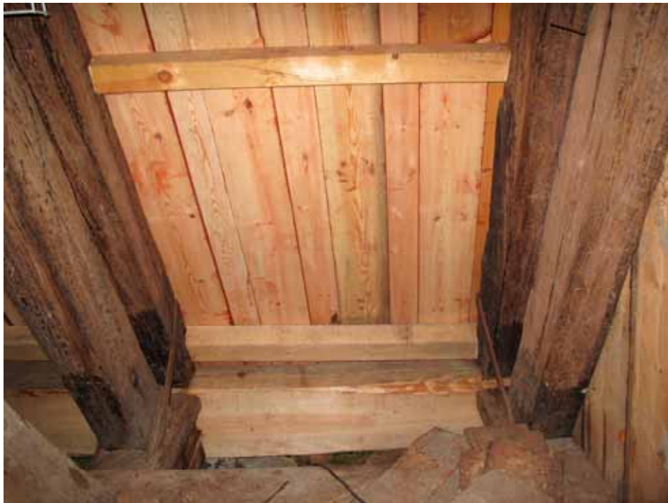
Västra sidans övriga knutar var i gott skick och kunde anslutas till den nya syllen. På bilden syns även de två utbytta reglarna, som utgör underlag för panelen. Lp20110068.
