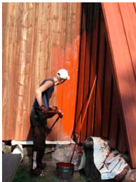
Tv. Panelbyte på nordsidan. Th. Målning av bevarad panel i sydösthörnet. Lp20110071 och Lp20110055.
