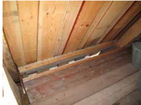
Tv. Sydvästra hörnet från insidan efter reparation av syll och bjälke. Befintliga järnband återanvändes. Th. Utrymmet mellan trägolvet och väggen täts med metallnät. Lp20110067 och Lp20110059.
