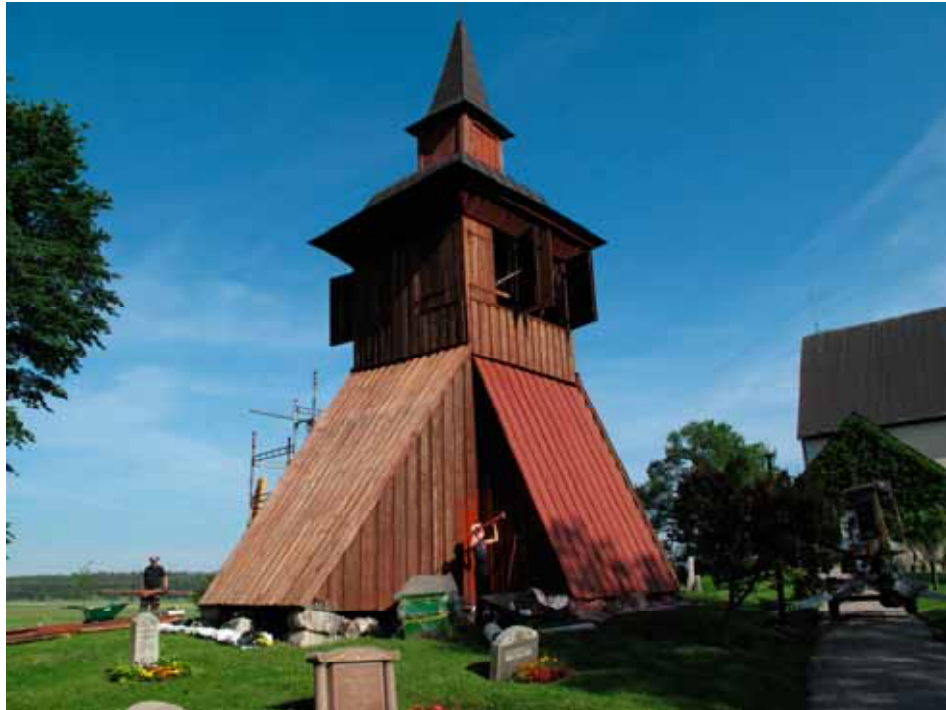
Klockstapeln från sydöst under pågående målning. Fasadpanelen var i gott skick på både södra och östra sidan. Infästningen förbättrades före målning. Lp20110054.
