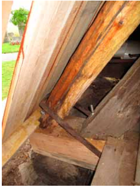
Norra sidans mittbjälke från väst respektive öst efter lagning. Yttre delen var rötskadad och lagades genom halvning. Lp20110070 och Lp20110069.
