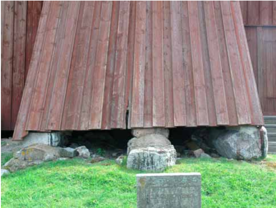
Västra sidan före åtgärd. Lp20110053.
