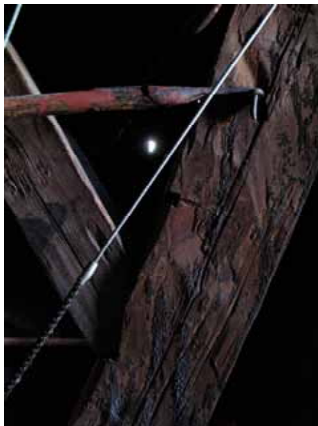
Tv. Detalj av hasp som håller en av luckorna på plats. Den handbilade stolpen har spår efter tjära. Th. Två av de tre hjärtstolparna består av två halva stockar sammanhållna med järnband. Dendroprov togs från den hela hjärtstolpen. Lp20110060 och Lp20110066.
