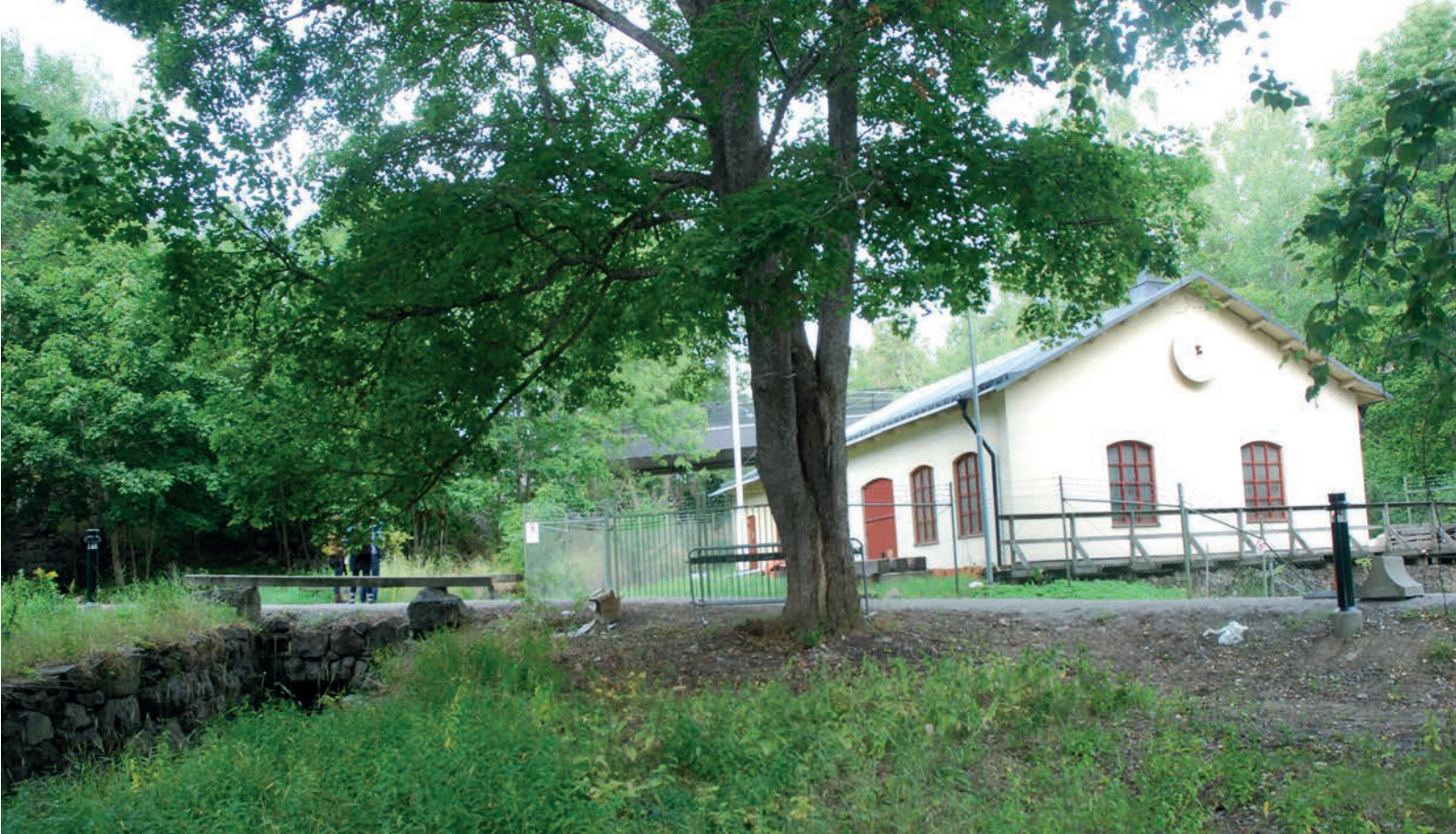
Uddby kraftstation byggdes 1897, efter ritningar av ingenjörbyrån Qvist & Gjers. Arkitekturen är typisk för industribyggnader från denna tid. Foto: Rolf Hammarskiöld.
