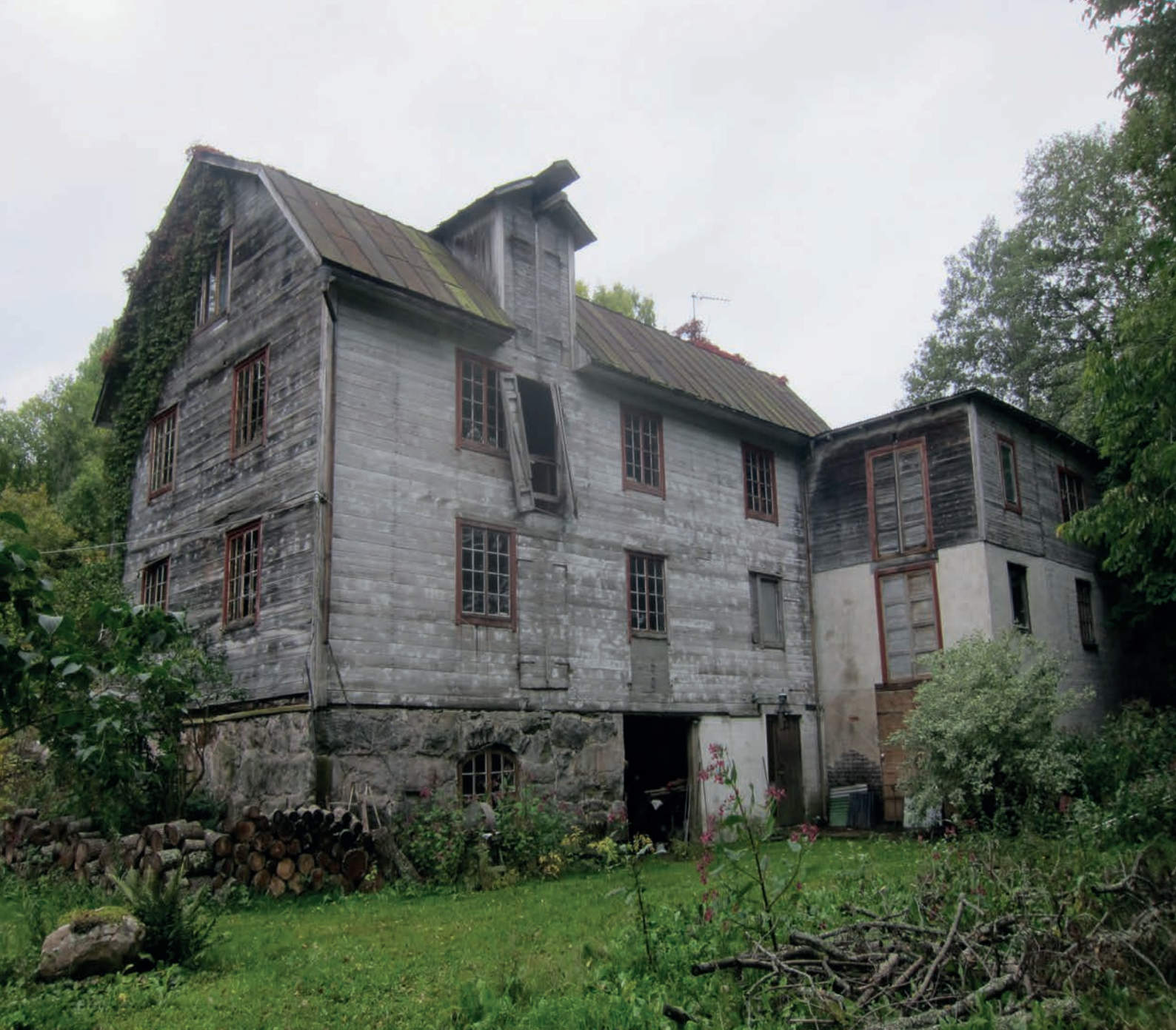
Karlösa kvarn i sitt befintliga omfång är från början av 1900-talet. Möjligen har den östra gråstensmurade delen ingått i en tidigare konstruktion. Foto: Moa Beskow
