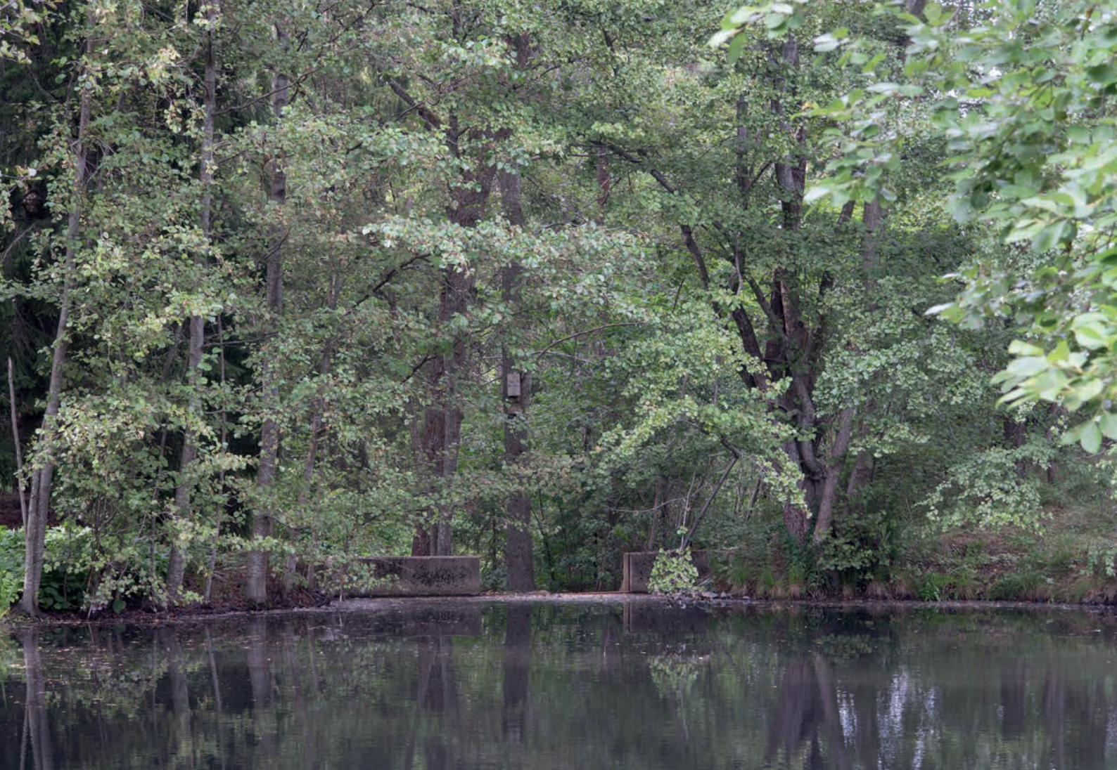
Den tidigare sågverksdammen har på 1900-talet ersatts med dagens större regleringsdamm, numera i bruk som dagvattendamm. Vart tionde år torrläggs dammen för att gräva bort ansamlad sediement. Foto: Jan af Geijerstam.
