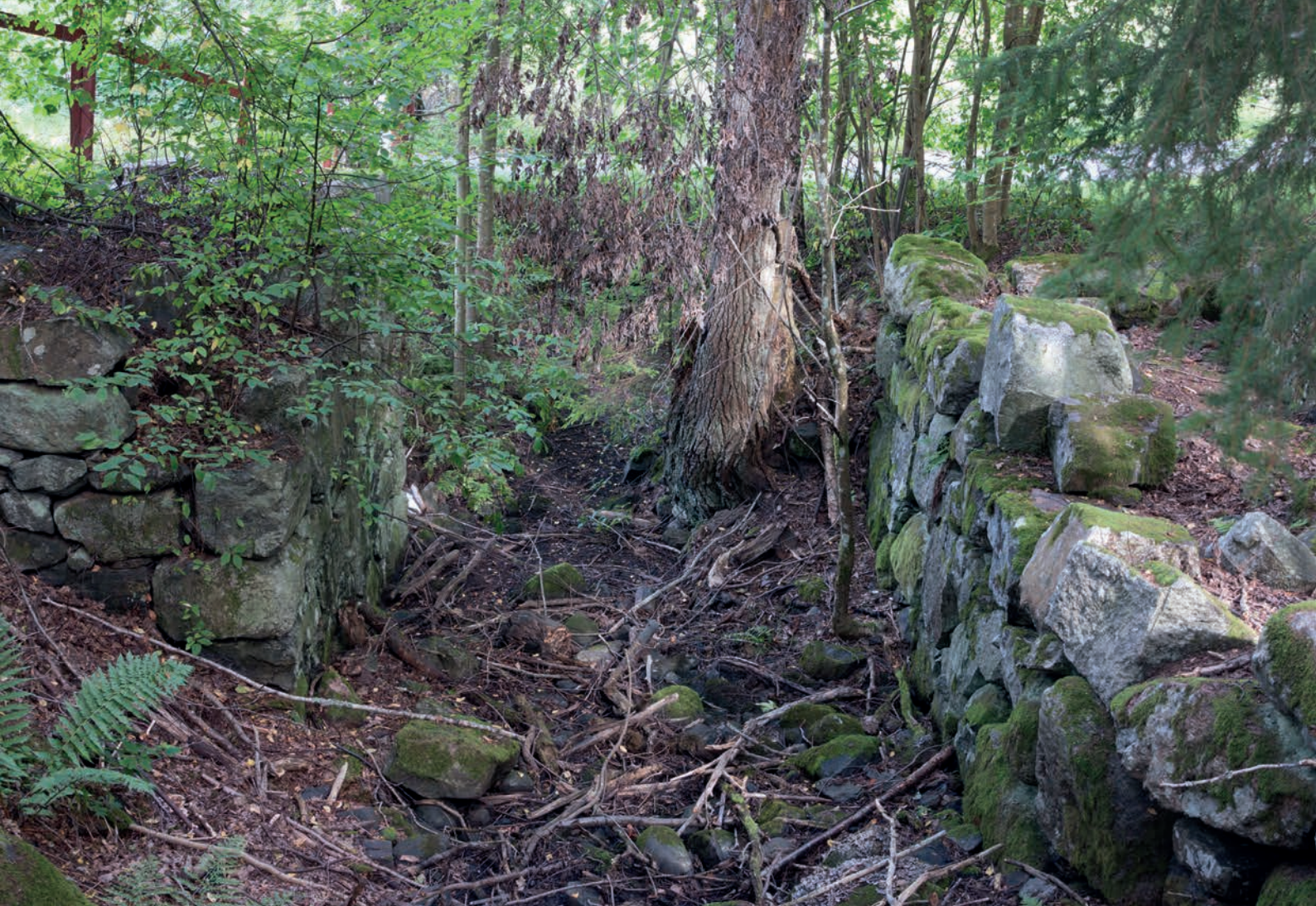
Nedströms nuvarande regleringsdammen i Fullersta finns murade vallar och grundmur efter tidigare kvarn. Foto: Jan af Geijerstam.
