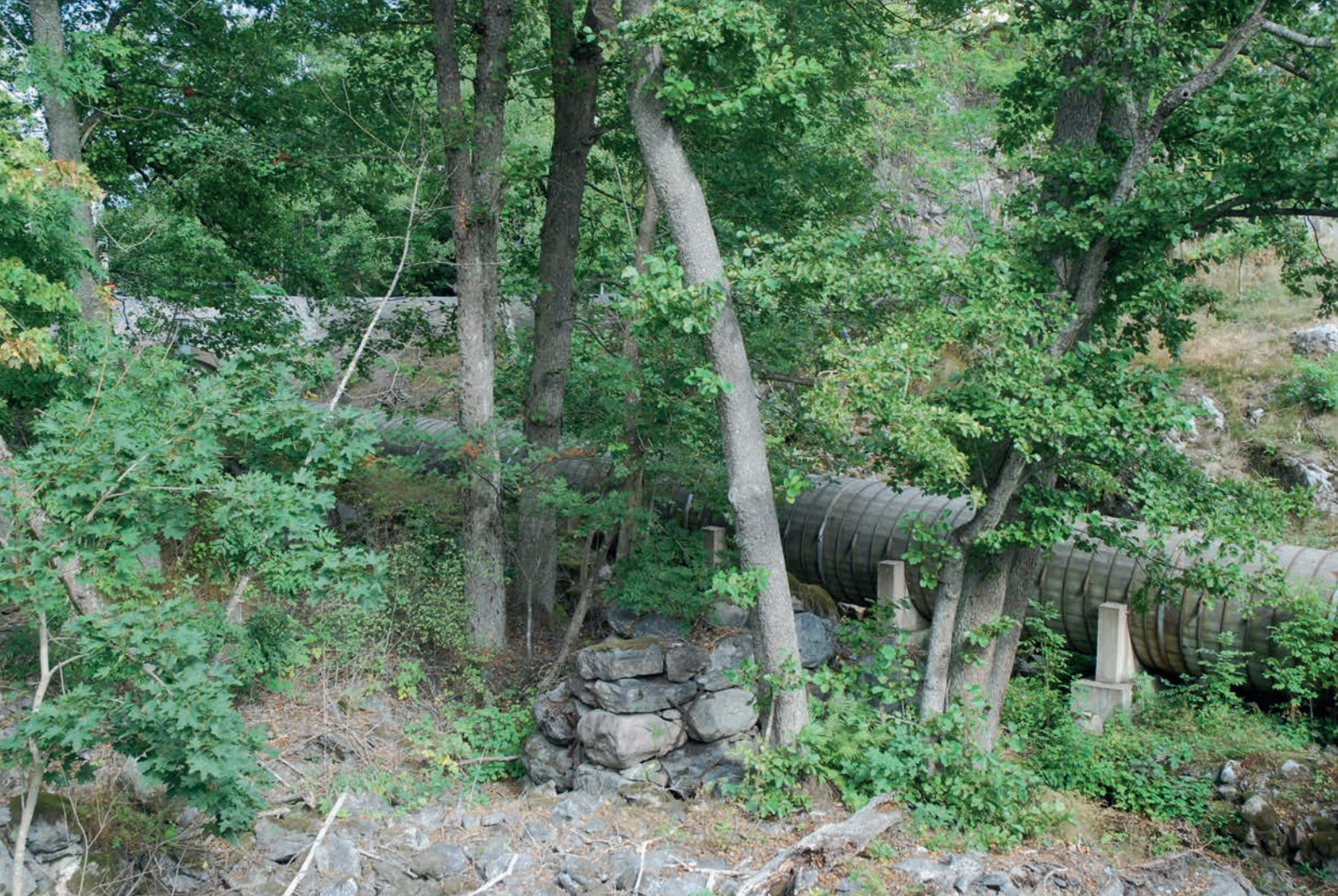
Till Uddby kraftstation leder en tillloppstup i trä, från 1983. I förgrunden ses fundament efter en sågverksbyggnad. Foto: Rolf Hammarskiöld.
